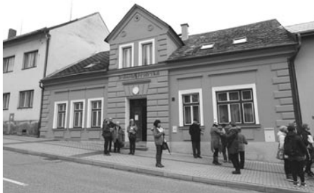
nově opravený sborový dům v Rovensku
