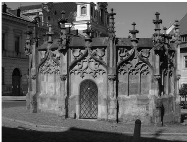
Kamenná kašna na Rejskově náměstí v Kutné Hoře s charakteristickým typem lomeného oblouku, užívaným v době vlády Jagellonců. (Zdroj: Wikipedia Commons / Autor: Michal Bjalek)
